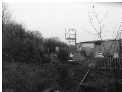
la tour de gué au 2 ème jour de construction levée à la main
